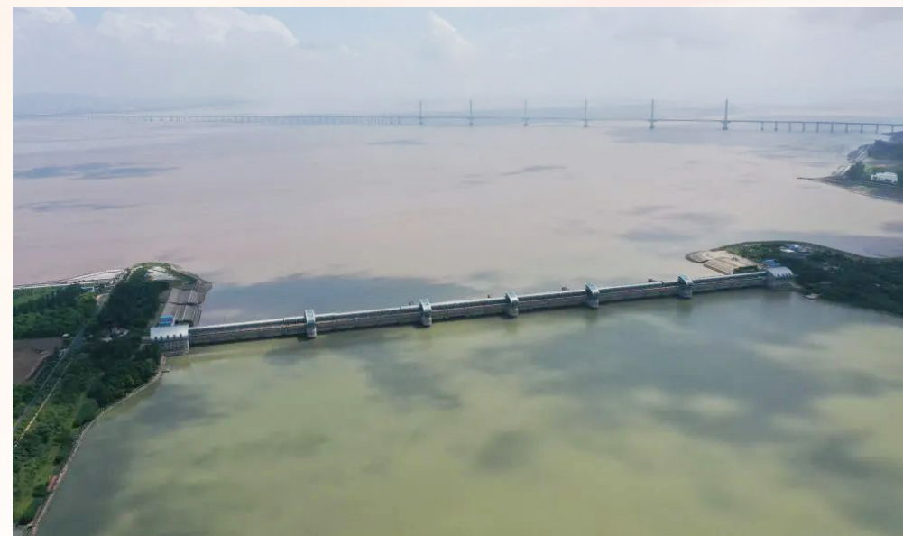
▲2023年8月4日拍摄的曹娥江大坝（无人机照片）。新华社记者黄宗治摄
